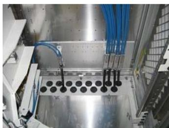
Les tubes sont acheminés vers chaque tiroir. Des dispositifs sont positionnés en fond de baie pour guider et accrocher les tubes sur toute la hauteur de l'armoire.
