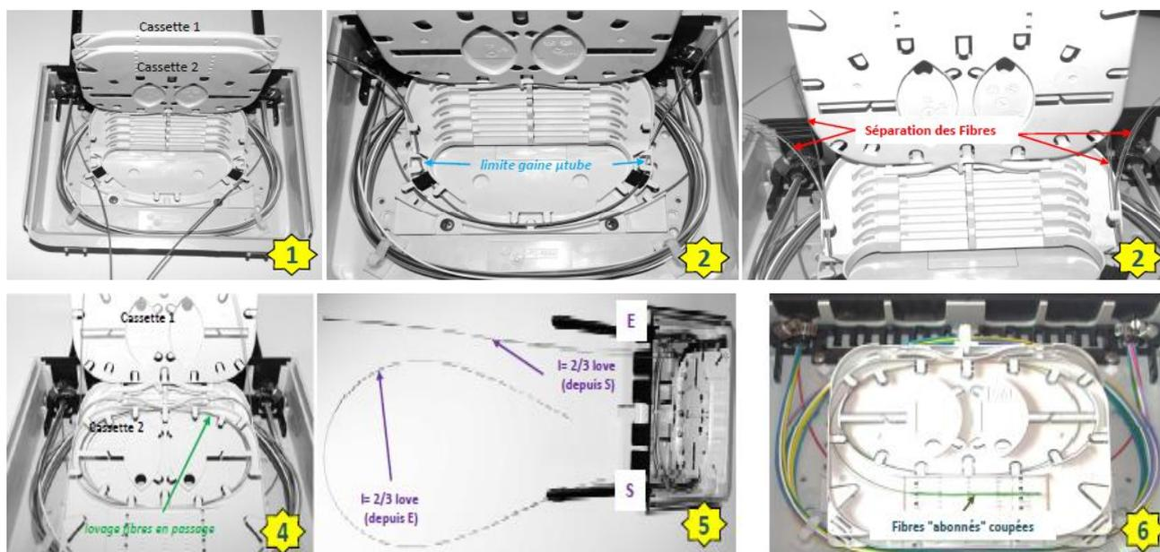
Dans le cas d'un boîtier terminal, le(s)  $\mu$ tube(s) contenant les fibres « Clients Finals » est dégainé(s). Les fibres « Clients Finals » sont lovées en cassette 1 et le solde des fibres est lové en cassette 2.
