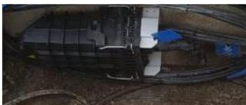
Les câbles sont identifiés en entrée et sortie de l'équipement en plus des étiquettes présentes au niveau des alvéoles.
